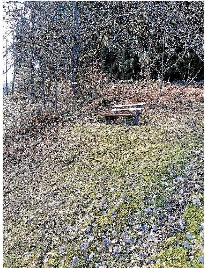
Säuberungsarbeiten am Wingertbuckel
