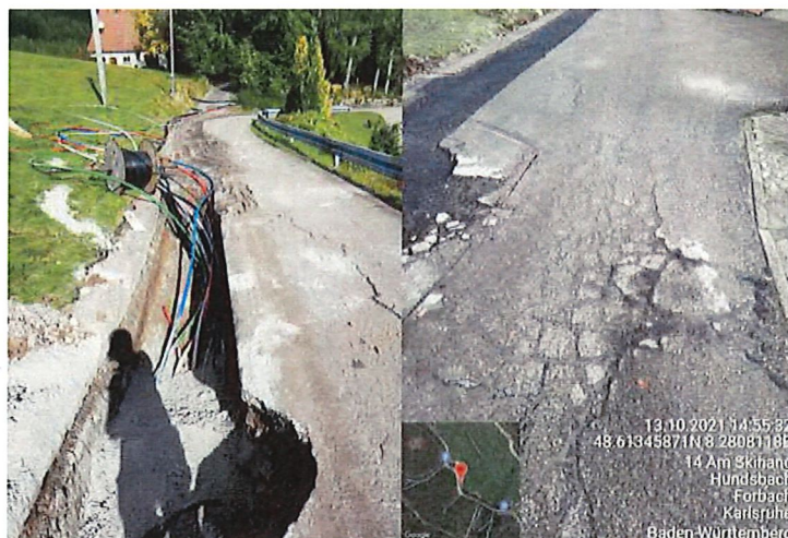
Abbildung 7: Wegbrechen der Straßenoberfläche bei Herstellung von Baugraben in Forbach-Hundsbach
