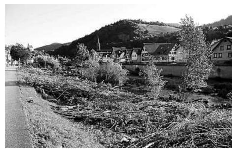
wird nicht nur der Blick über die Murg wieder ermöglicht, sondern auch ein wesentlicher Beitrag zum Hochwasserschutz geleistet. Denn durch den Rückschnitt der Gehölze wird der Wasserabfluss bei Hochwasserereignissen wiederum gewährleistet. Man erinnere sich in diesem Zusammenhang nur an den 13. Januar 2004, als nur wenige Kilometer murgabwärts der Gernsbacher Tunnel von Hochwasser geflutet wurde.
