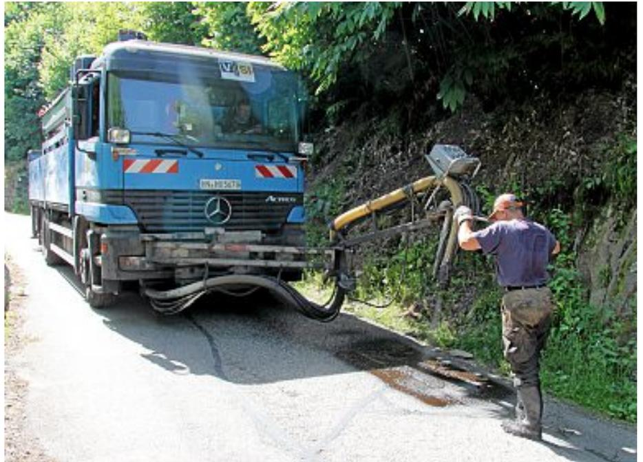
Die Beseitigung der Schäden erfolgte mit der Spezialmaschine in drei Arbeitsschritten. Zunächst wurde die Schadensstelle mit Druckluft ausgeblasen und sodann eine Haftbrücke mit Bitumen-Emulsion aufgebracht.
