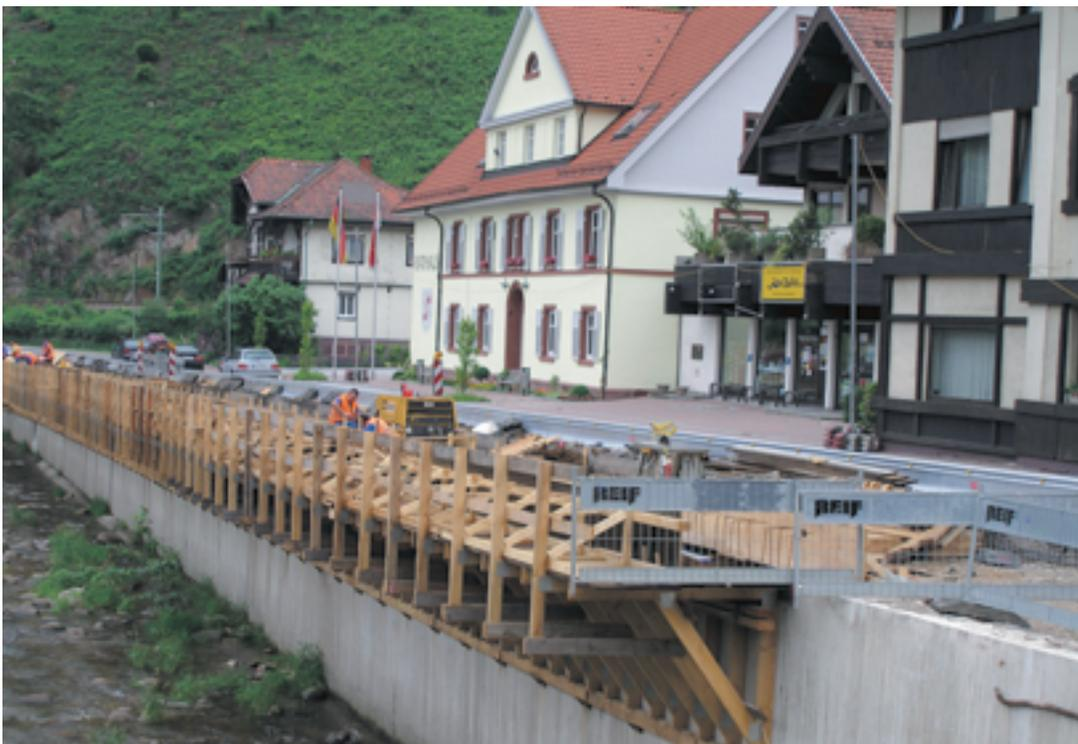
Derzeit sind die Sanierungsarbeiten an der Stützmauer und am Gehweg entlang der B 462 im Gange.
