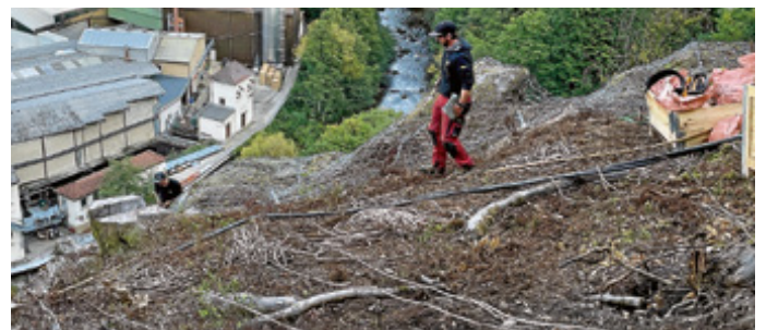
Die Netze werden über den Hang gespannt
