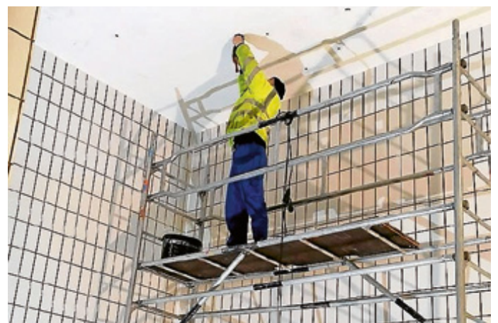
Lampentausch in der Filterkammer im Hochbehälter
