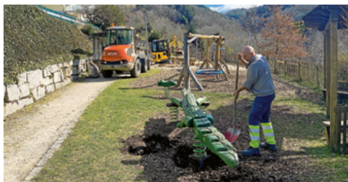
Der Bauhof beim Herrichten des Kinderspielplatzes Birket
