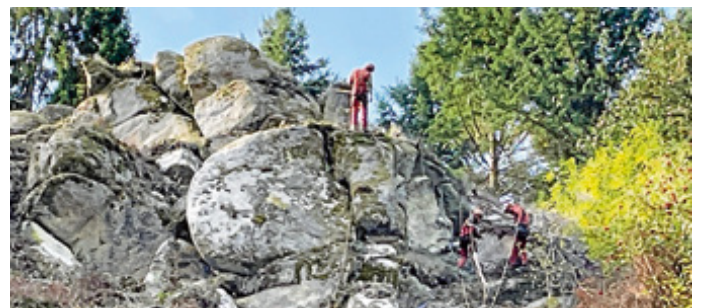
Die Arbeiter seilen sich am Hang ab
