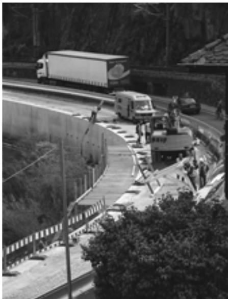
Seit Mitte April sind die Bauarbeiten zur Instandsetzung der Stützmauer und Gehwegkappe an der B 462 entlang der Murg von der Murgbrücke in Richtung Hilpertsau im Gange. Da bedingt durch diese Arbeiten lediglich eine Fahrspur zur Verfügung steht, ist eine Verkehrsregelung mittels Ampelanlage erforderlich. Naturgemäß bringen solche Verkehrsbeschränkungen Wartezeiten vor roten Ampeln mit sich.
