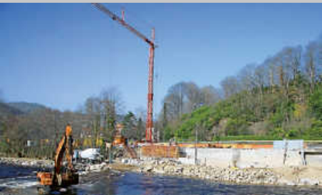
Bau der Radwegbrücke schreitet voran
