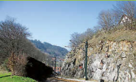
Felssicherung an der AVG-Strecke
