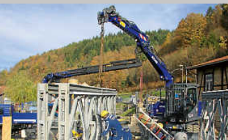
Bau der Behelfsbrücke in der Unteren Schlechtau
