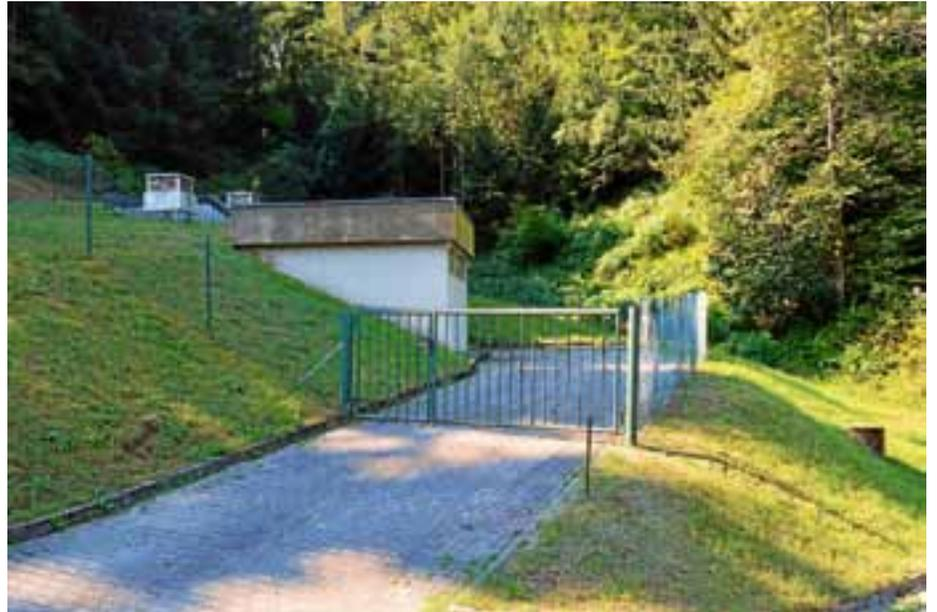
te wurden bis zum Hochbehälter im Gewann „Gerstenland“ mit einem maximalen Wasserspiegel von 336 Meter über NN. gebaut. Dort sorgen zwei Kammern mit einem Volumen von jeweils 400 cbm für Versorgungssicherheit. Rund 4 Millionen DM kostete das sich über rund 4 Jahre hinziehende Großprojekt „Sicherstellung der Wasserversorgung“, wozu neben Quellfassungen und Hochbehälter auch die Zuleitung ins Dorf und die Wasserverteilung in Weisenbach und Au gehörten.
